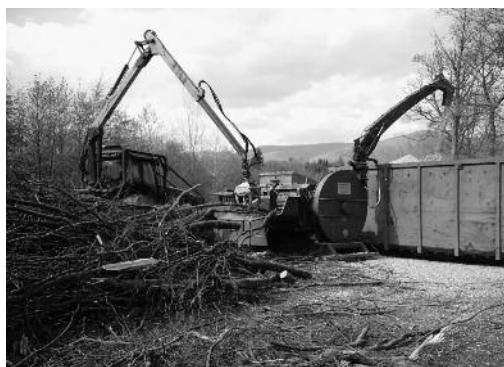
Le bois frais est directement transformé en plaquettes, puis transporté sous le hangar de stockage d'Etueffont, distant de 5 km du chantier forestier.
